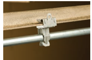
Conduit to Beam Clip
